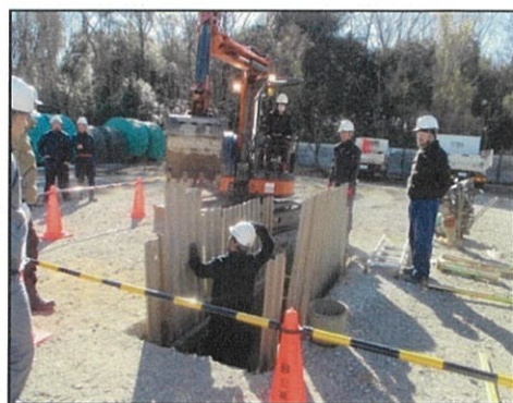
冬期 基本動作反復訓練の実施 (電工班による昇柱訓練と土木班による土止め支保工訓練状況)
