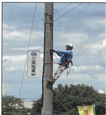
夏期 基本動作反復訓練の 実施 (電工班による昇柱訓練 状況)
