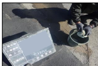
路面カッター 濁水清掃実施
