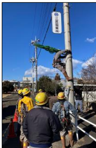
冬期 基本動作反復訓練の実施 （電工班による昇柱及び落下防 止ネット装着訓練と土木班に よるケーブルドラム取扱訓練 状況）
