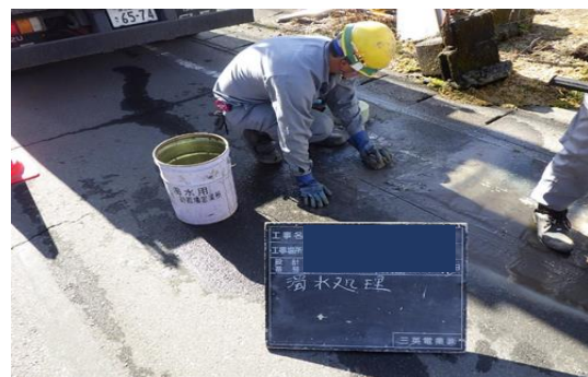
路面カッター 濁水清掃実施
